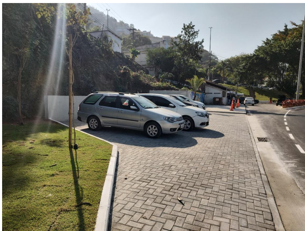
Figura 3 – Detalhe da área indicada. Acabado do piso em blocos intertravado. Foto de agosto de 2025.
